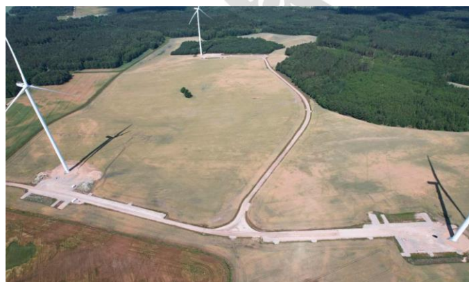
Rokiškis wind park turbines
